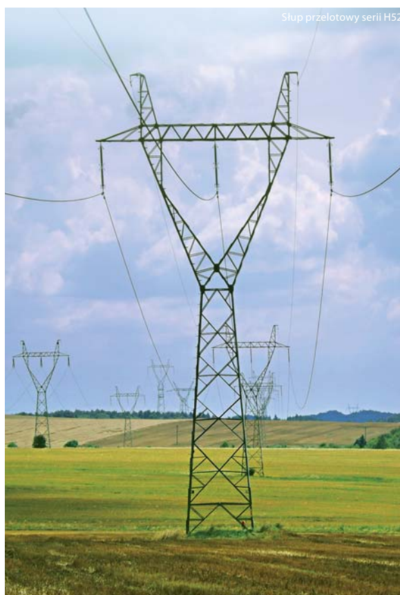
Linia elektroenergetyczna 220 kV relacji Łośnice – Siersza
