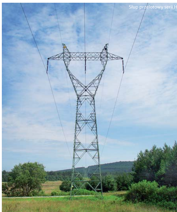
Linia elektroenergetyczna 220 kV relacji Łośnice – Kielce
